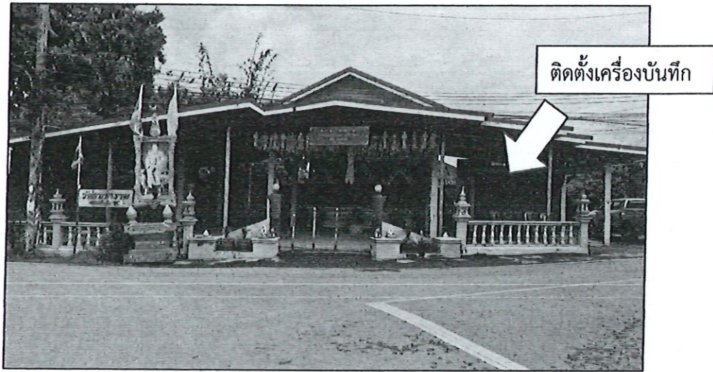
จุดติดตั้งเครื่องบันทึก บริเวณศาลารวมใจ (หอพ่อบ้าน)
