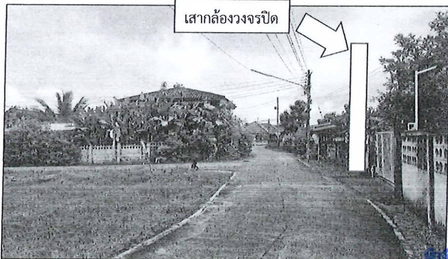
จุดติดตั้งกล้องตัวที่ ๕ จุด ๓ แยกท้ายหมู่บ้าน พิกัด N ๑๘.๘๕๖๖๘๓ E ๙๙.๑๑๕๒๐๙
