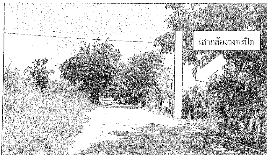
จุดติดตั้งทางเชื่อมหมู่ ๑ บ้านป่าตึงน้อย ต.ป่าป้อ พิกัด N ๑๘.๘๖๑๐๒๙ E ๙๙.๑๕๕๐๓๕
