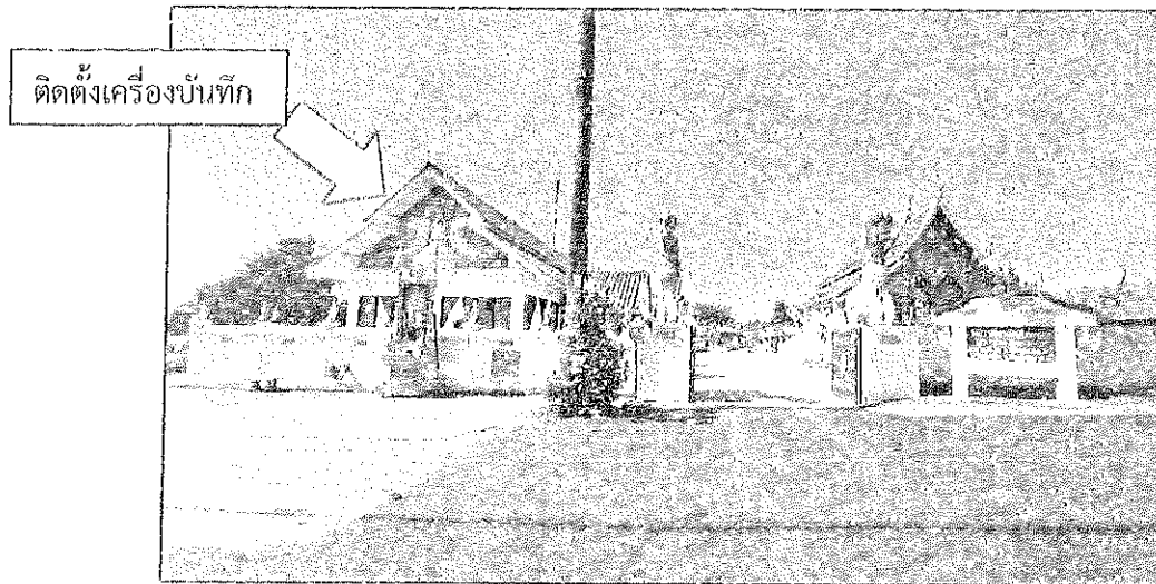
จุดติดตั้งเครื่องบันทึก วัดนิเวศไพโรสมณี พิกัด N ๑๘.๘๖๒๒๕๖ E ๙๙.๑๕๒๐๗๖
