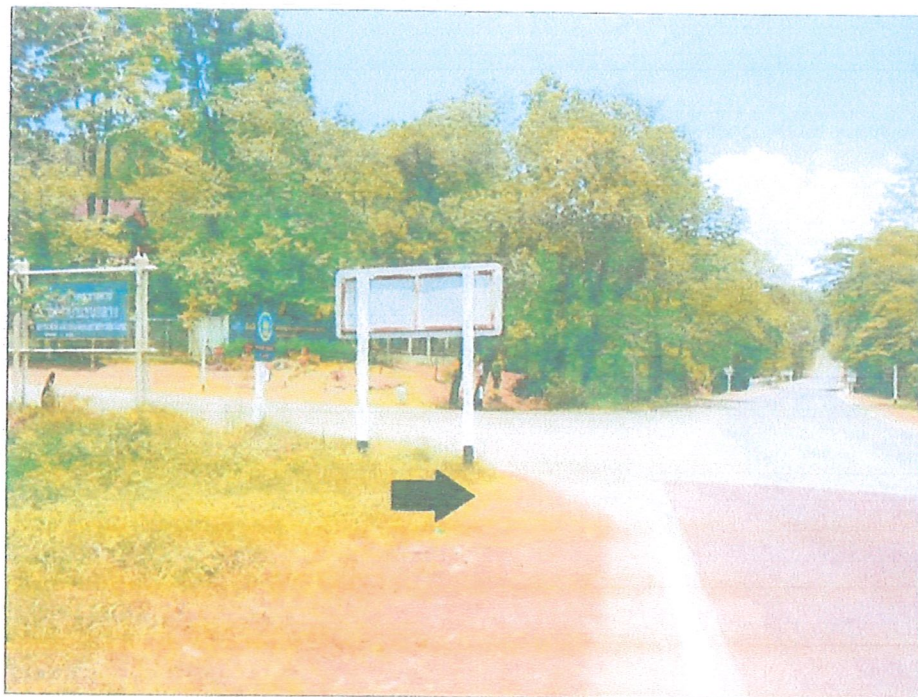
จุดติดตั้ง CCTV.สามแยก ทล.1009 และ ทล.1284
