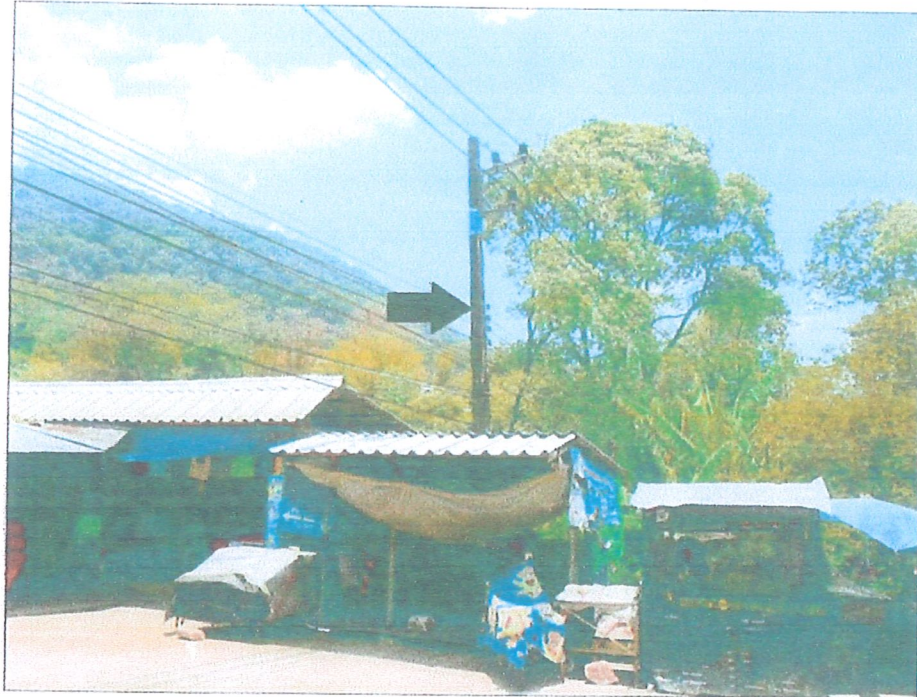
จุดติดตั้ง CCTV. กล้องที่ 3 ตลาดชุมชนชาวไทยม้ง
