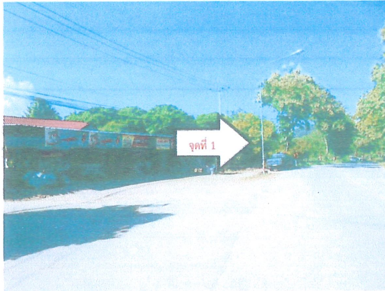
จุดติดตั้ง CCTV กล้องที่ 1, 2 สามแยกปากแตร
