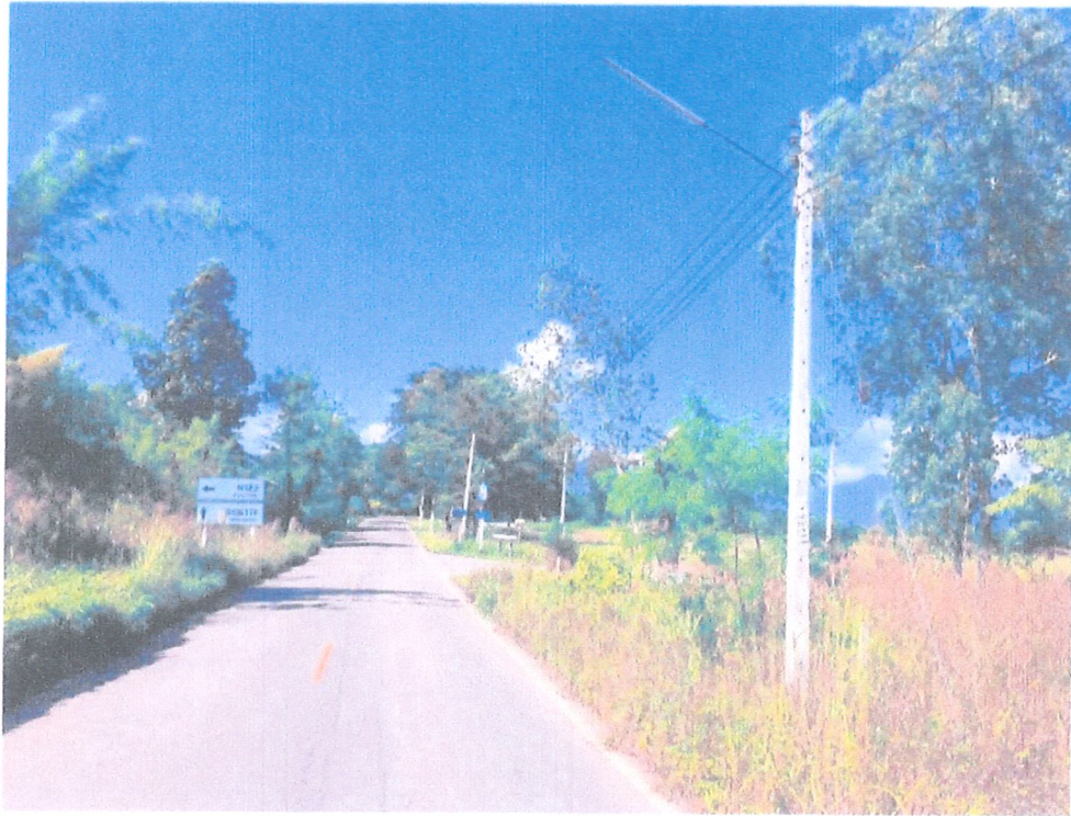
จุดติดตั้งกล้องโทรทัศน์วงจรปิด ( CCTV System ) จุดที่ 6
