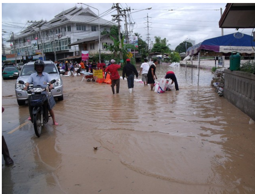
รูปที่ 8 ทางลอดสะพานภาค 5 เมื่อปี 2554
