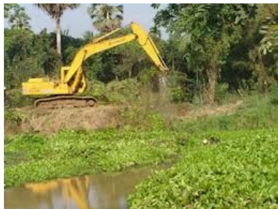
รูปที่ 18 การขุดลอกและกำจัดวัชพืชในแหล่งน้ำและคลอง
