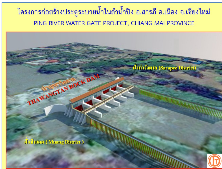
รูปที่ 33 โครงการก่อสร้างประตูระบายน้ำในลำน้ำปิง (ปตร.ท่าวังตาล) เพื่อเพิ่มประสิทธิภาพการระบายน้ำของแม่น้ำปิง ช่วงที่ไหลผ่านตัวเมืองเชียงใหม่
