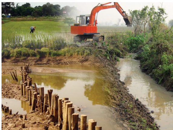
รูปที่ 18 การขุดลอกและกำจัดวัชพืชในแหล่งน้ำและคลอง
