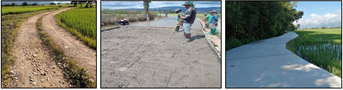
ก่อสร้างถนนคอนกรีตเสริมเหล็ก บริเวณถนนบ่อขยะบ้านป่าเสี้ยวถึง บ้านแม่กอย หมู่ที่ ๖ ตำบลเวียง อำเภอพร้าว จังหวัดเชียงใหม่ ขนาดกว้าง ๔.๐๐ เมตร ยาว ๑,๔๙๖.๐๐ เมตร หน้า ๐.๑๕ เมตร งบประมาณ ๒,๔๑๐,๐๐๐ บาท
