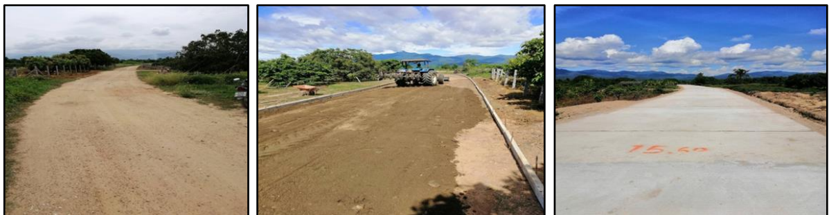
ก่อสร้างถนนคอนกรีตเสริมเหล็ก บ้านแม่เหียะ หมู่ที่ ๒ ตำบลแม่แวน อำเภอพร้าว จังหวัดเชียงใหม่ กว้าง ๕.๐๐ เมตร ยาว ๔๙๙.๐๐ เมตร หนา ๐.๑๕ เมตร หรือมีพื้นที่ไม่น้อยกว่า ๒,๔๙๕ ตารางเมตร งบประมาณ ๙๘๕,๐๐๐ บาท
