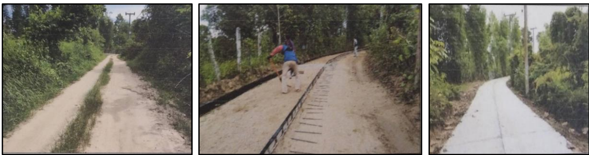
ก่อสร้างถนนคอนกรีตเสริมเหล็ก บ้านสันป่ายาง หมู่ที่ ๒ ตำบลสันป่ายาง อำเภอแม่แตง จังหวัดเชียงใหม่ ขนาดกว้าง ๔.๐๐ เมตร ยาว ๖๘๖.๐๐ เมตร หนา ๐.๑๕ เมตร พร้อมลงดินไหล่ทาง งบประมาณ ๑,๐๙๐,๐๐๐ บาท
