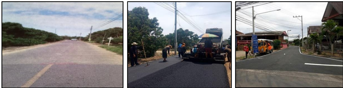
ปรับปรุงผิวจราจรแบบ Over Lay ด้วยแอสฟัลติกคอนกรีต ถนนสาย หมู่ ๒ บ้านมะขามหลวง ตำบลมะขามหลวง เข้ม หมู่ ๕ บ้านมะขุนหวาน ตำบลมะขุนหวาน อำเภอสันป่าตอง จังหวัดเชียงใหม่ ขนาดกว้าง ๕.๐๐ เมตร ยาว ๗๙๕ เมตร หรือมีพื้นที่ไม่น้อยกว่า ๓,๙๗๕ ตารางเมตร งบประมาณ ๘๕๗,๐๐๐ บาท
