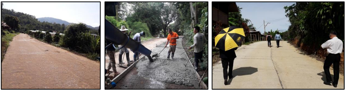
ก่อสร้างถนนคอนกรีตเสริมเหล็กภายในเขตตำบลสะเมิงเหนือ สายทางบ้านป้อก หมู่ที่ ๕ ตำบลสะเมิงเหนือ อำเภอสะเมิง เชื่อมต่อบ้านโป่งไคร้ หมู่ที่ ๕ ตำบลโป่งแยง อำเภอแมริม จังหวัดเชียงใหม่ ขนาดกว้าง ๕.๐๐ เมตร ยาว ๗๐๐.๐๐ เมตร หนา ๐.๑๕ เมตร งบประมาณ ๑,๕๓๐,๐๐๐ บาท
