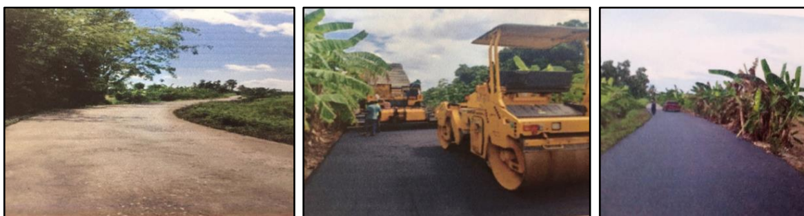
ปรับปรุงผิวจราจรแบบ Over Lay ด้วยแอสฟัลติกคอนกรีต ถนนสาย หมู่ ๙ บ้านดงขี้เหล็ก ตำบลมะขามหลวง อำเภอสันป่าตอง จังหวัดเชียงใหม่ เข้มหมู่ ๖ บ้านดงป่าซาง ตำบลมะขุนหวาน อำเภอสันป่าตอง จังหวัดเชียงใหม่ ขนาด กว้าง ๔.๐๐ เมตร ยาว ๖๕๐ เมตร หรือมีพื้นที่ไม่น้อยกว่า ๒,๖๐๐ ตารางเมตร งบประมาณ ๕๑๔,๐๐๐ บาท
