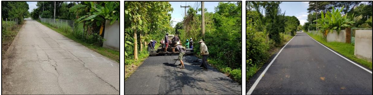
ปรับปรุงผิวถนนเดิมด้วยแอสฟัลติก ถนนสายทางหน้าค่าย กก.ตชด.๓๓ (ผ่านหน้าศิริลักษณ์รีสอร์ท) หมู่ที่ ๗ ถึงป้อมชุดรักษาความปลอดภัยหมู่บ้าน หมู่ที่ ๑๓ ตำบลหนองหาร อำเภอสันทราย จังหวัดเชียงใหม่ กว้าง ๔.๐๐ เมตร ยาว ๑,๗๕๐.๐๐ เมตร งบประมาณ ๑,๔๓๗,๐๐๐ บาท
