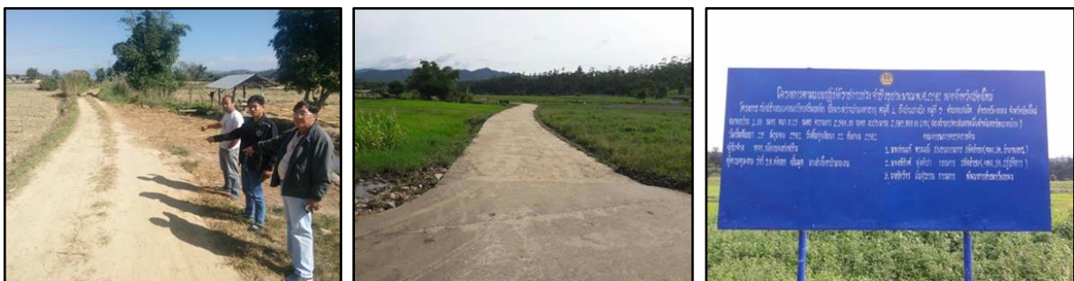
ก่อสร้างถนนคอนกรีตเสริมเหล็กเชื่อมระหว่างบ้านมหาธาตุ หมู่ที่ ๔ ถึง บ้านปางป๋อ หมู่ที่ ๕ ตำบลแสนไห อำเภอเวียงแหง จังหวัดเชียงใหม่ กว้าง ๔.๐๐ เมตร หนา ๐.๑๕ เมตร ความยาว ๒,๓๘๘.๐๐ เมตรงบประมาณ ๒,๘๖๕,๖๐๐ บาท
