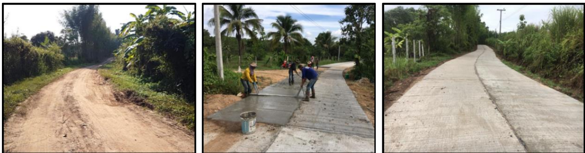
ก่อสร้างถนนคอนกรีตเสริมเหล็กสายบ้านสันป่ายาง - สันป่าตึง ตำบลสันป่ายาง อำเภอแม่แตง จังหวัดเชียงใหม่ ขนาด ๔.๐๐ เมตร ยาว ๘๐๐.๐๐ เมตร หนา ๐.๑๕ เมตร พร้อมลงดินไหล่ทางงบประมาณ ๑,๒๖๔,๐๐๐ บาท
