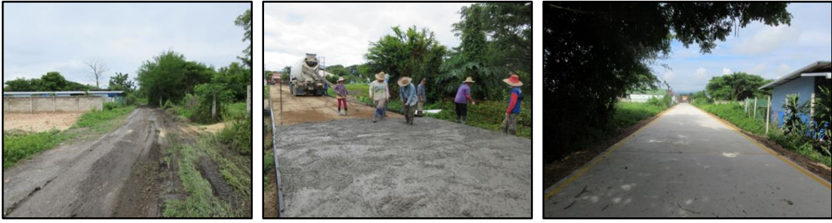
ก่อสร้างถนนคอนกรีตเสริมเหล็ก พร้อมตีเส้นจราจร บริเวณถนนซอยตรงข้ามโรงเรียนบ้านป่าบาง (ซอย ๑๒ ใหม่) หมู่ที่ ๑ ตำบลหนองหาร อำเภอสันทราย จังหวัดเชียงใหม่ ขนาดกว้าง ๕.๐๐ เมตร ยาว ๕๓๕.๐๐ เมตร หนา ๐.๑๕ เมตร หรือพื้นที่ดำเนินการไม่น้อยกว่า ๒,๖๗๕ ตารางเมตร งบประมาณ ๑,๑๙๙,๐๐๐ บาท
