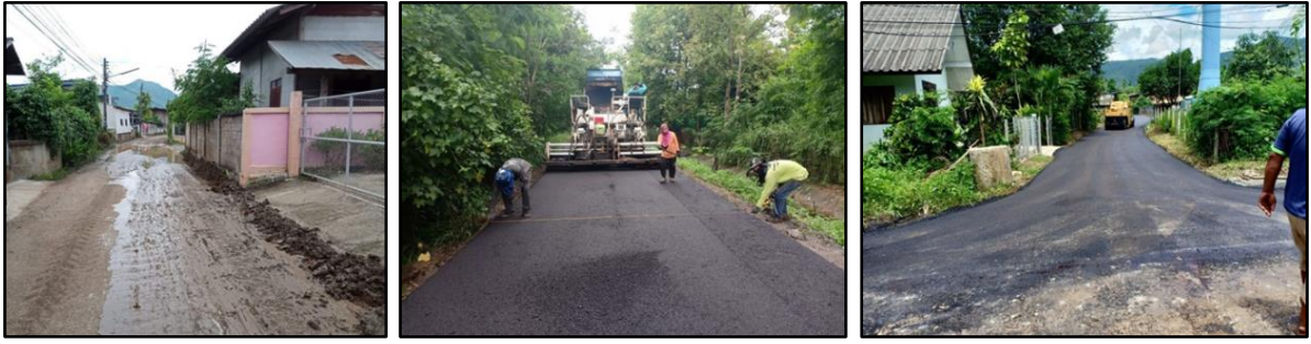
ปรับปรุงผิวจราจร (โอเวอร์เลย์) หมู่ที่ ๖ ตำบลอนกลาง อำเภอแม่อน จังหวัดเชียงใหม่ กว้าง ๔.๐๐ เมตร ยาว ๑,๓๕๐.๐๐ เมตร หนา ๐.๐๕ เมตร งบประมาณ ๑,๐๘๐,๐๐๐ บาท
