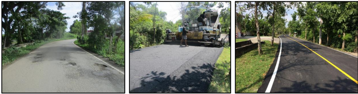
ปรับปรุงผิวถนนแอสฟัลท์ติกคอนกรีต (Over lay) หมู่ที่ ๓ เชื่อม หมู่ที่ ๒ ตำบลสันนาเม็ง อำเภอสันทราย จังหวัดเชียงใหม่ กว้าง ๕.๒๐ เมตร ยาว ๘๙๐.๐๐ เมตร หนา ๐.๐๕ เมตร หรือมีพื้นที่ไม่น้อยกว่า ๔,๖๒๘ ตารางเมตร งบประมาณ ๙๑๑,๗๑๗ บาท
