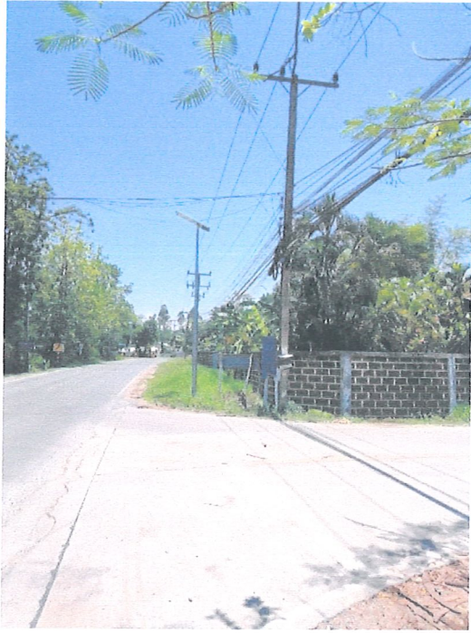
จุดติดตั้ง ที่ ๑
