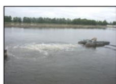
บ่อเติมอากาศที่ 2 เครื่องเติมอากาศ ขนาด 20 HP จำนวน 24 ชุด
