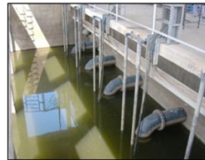
เครื่องสูบน้ำแบบจุ่ม เพื่อส่งน้ำเสีย ไปยังโรงงานปรับปรุงคุณภาพน้ำ
