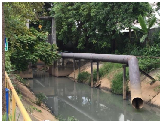
ท่อส่งน้ำจากสถานีสูบน้ำจากแม่น้ำปิงลงคลองแม่ข่าของเทศบาลนครเชียงใหม่
