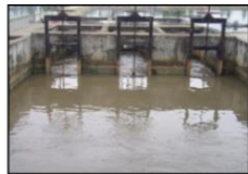
บ่อกระจายน้ำ
