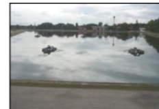
บ่อเติมอากาศที่ 1 เครื่องเติมอากาศ ขนาด 40 HP จำนวน 36 ชุด
