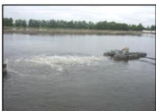
บ่อเติมอากาศที่ 2 เครื่องเติมอากาศ ขนาด 20 HP จำนวน 24 ชุด
