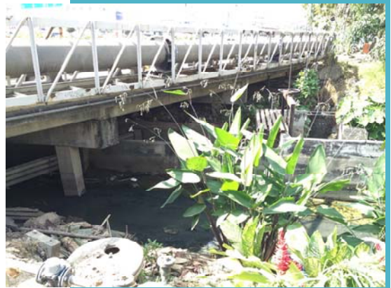
รางน้ำคอนกรีตที่เกิดขวางการไหลของน้ำในคลองแม่แฝด เป็นตัวอย่างที่จะทำการรื้อถอน
